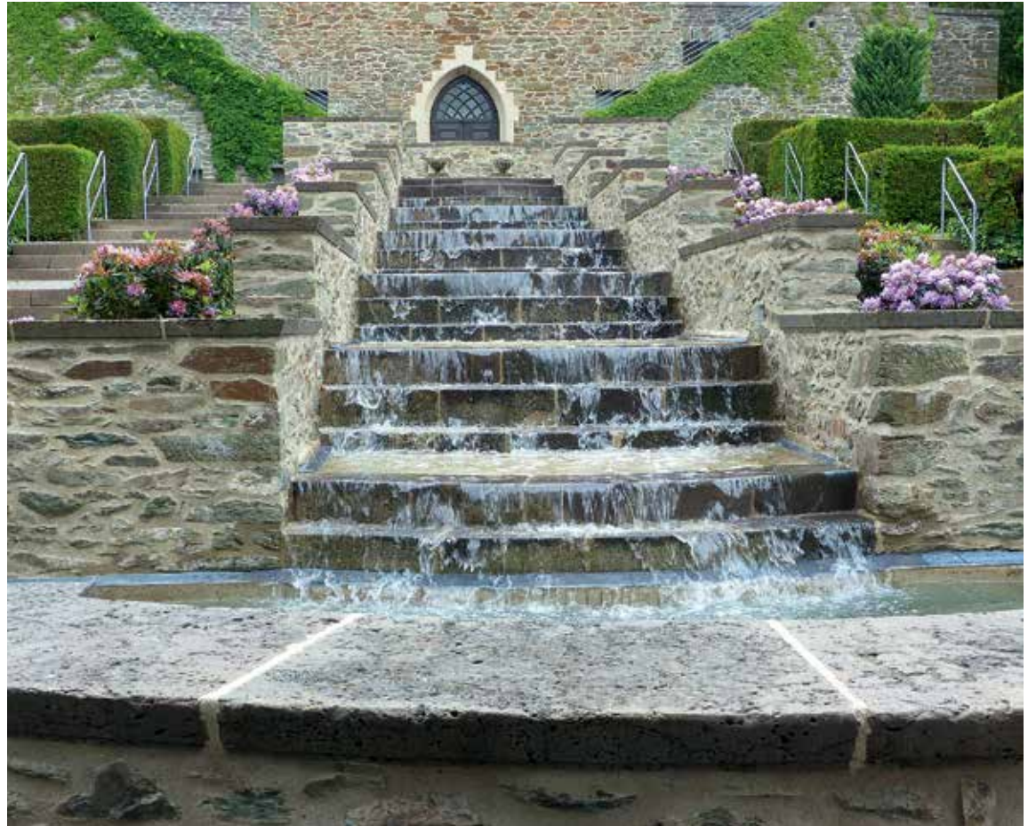
Nach sechs Jahrzehnten fließt wieder Wasser: Kaskade auf dem Alten Friedhof
