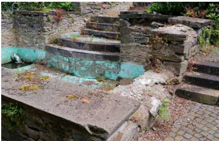
So sah die Kaskade vor der Sanierung aus
