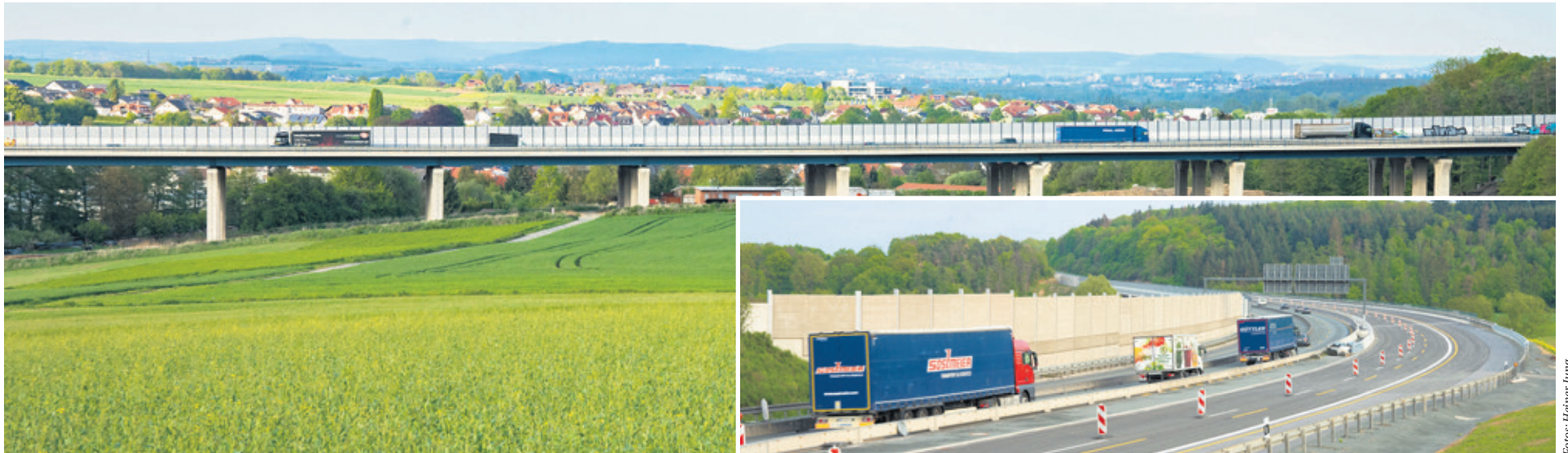
Die Bauarbeiten sind abgeschlossen, die lang ersehnte Lärmschutzwand tut ihren Dienst und der Verkehr läuft wieder normal vierspurig
