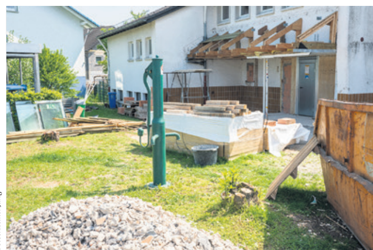
In der Kita Münchholzhausen gehen die Bauarbeiten voran
