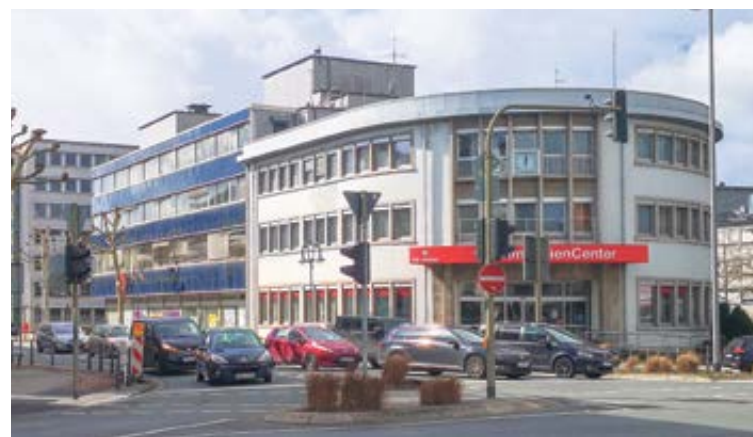
Kreisverwaltung baut an: Der frühere Rundbau der Sparkasse aus den 50er Jahren
