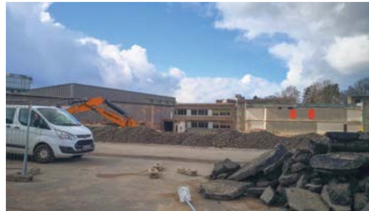
Das Baufeld für die neue Goethe-Schule wird vorbereitet
