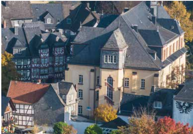
Die Musikschule auf dem Schillerplatz muss saniert werden
