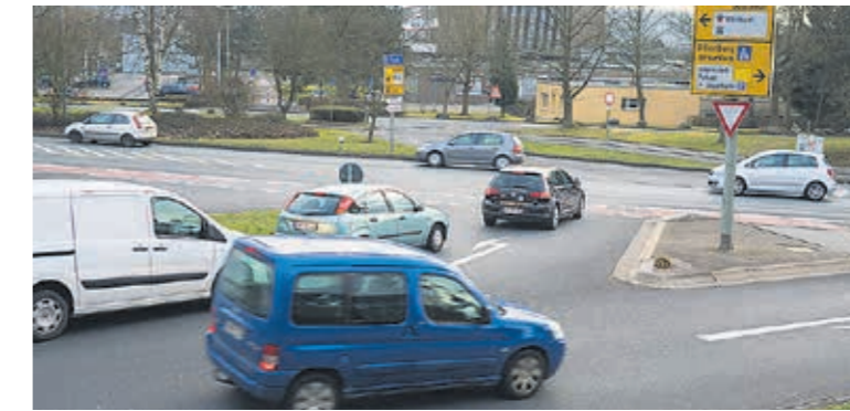
Umbau des Verkehrsknotenpunkts im Bereich der „Franzenburg“ in Wetzlar
